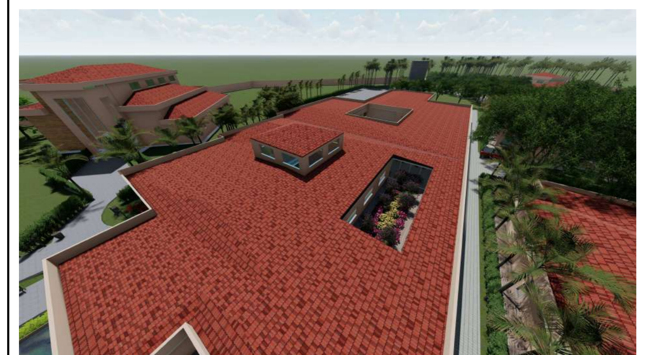
VISTA - SUPERIOR BLOCO ADM. E EVENTOS
