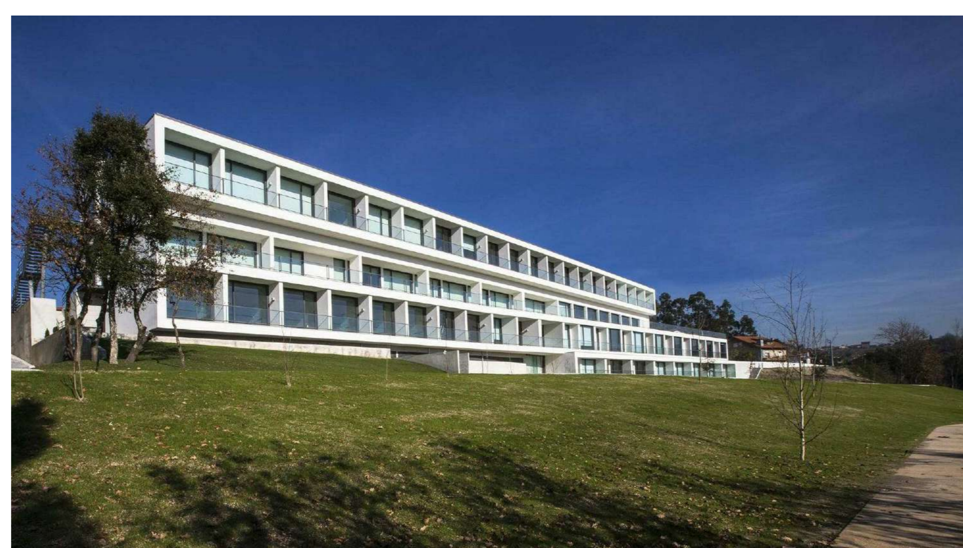
LAR RESIDENCIAL TORRE SÊNIOR - ATELIER J.A. LOPES DA COSTA SANTO TIRSO - PORTUGAL
