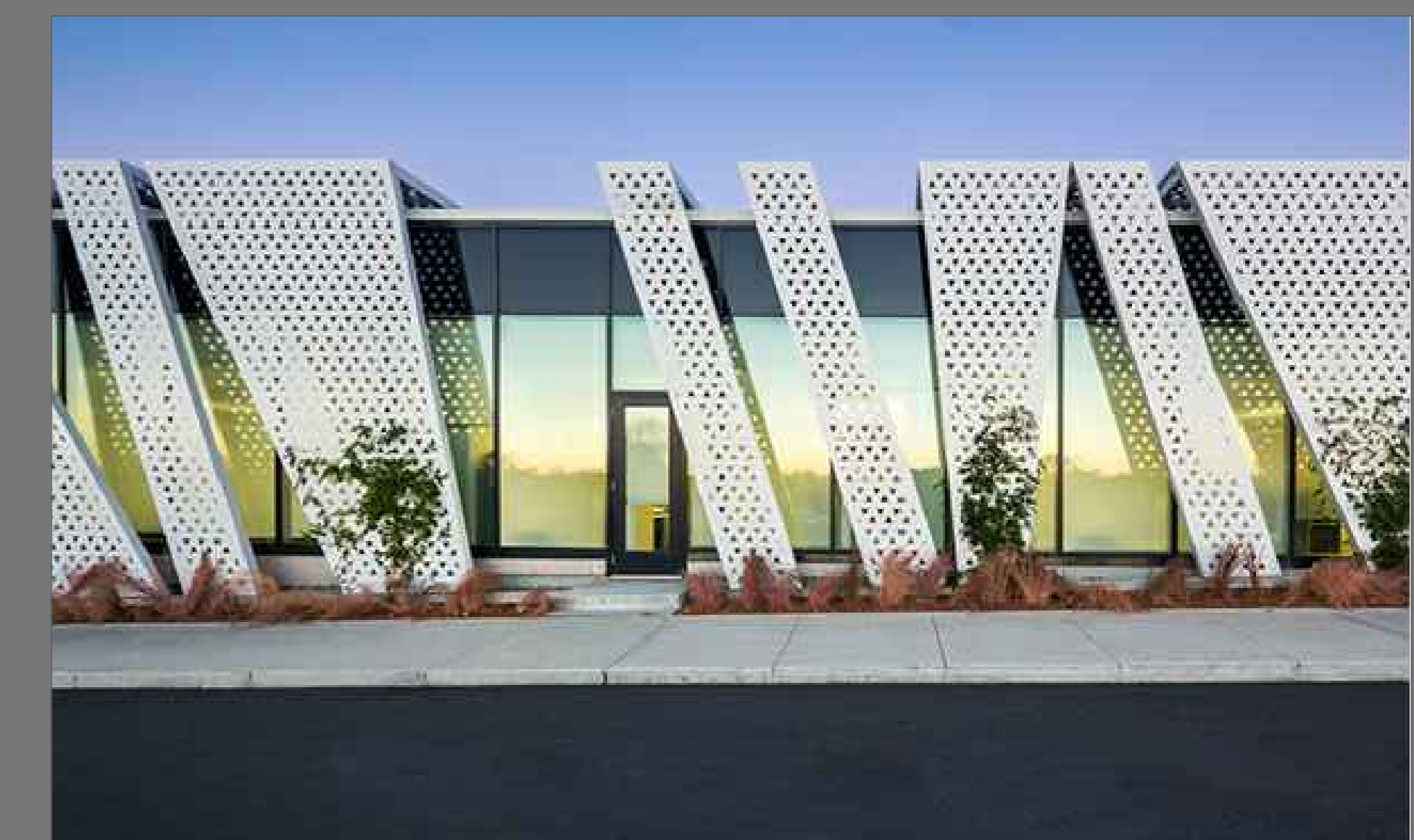
Revitalização do Casino, Montreal, Canadá
