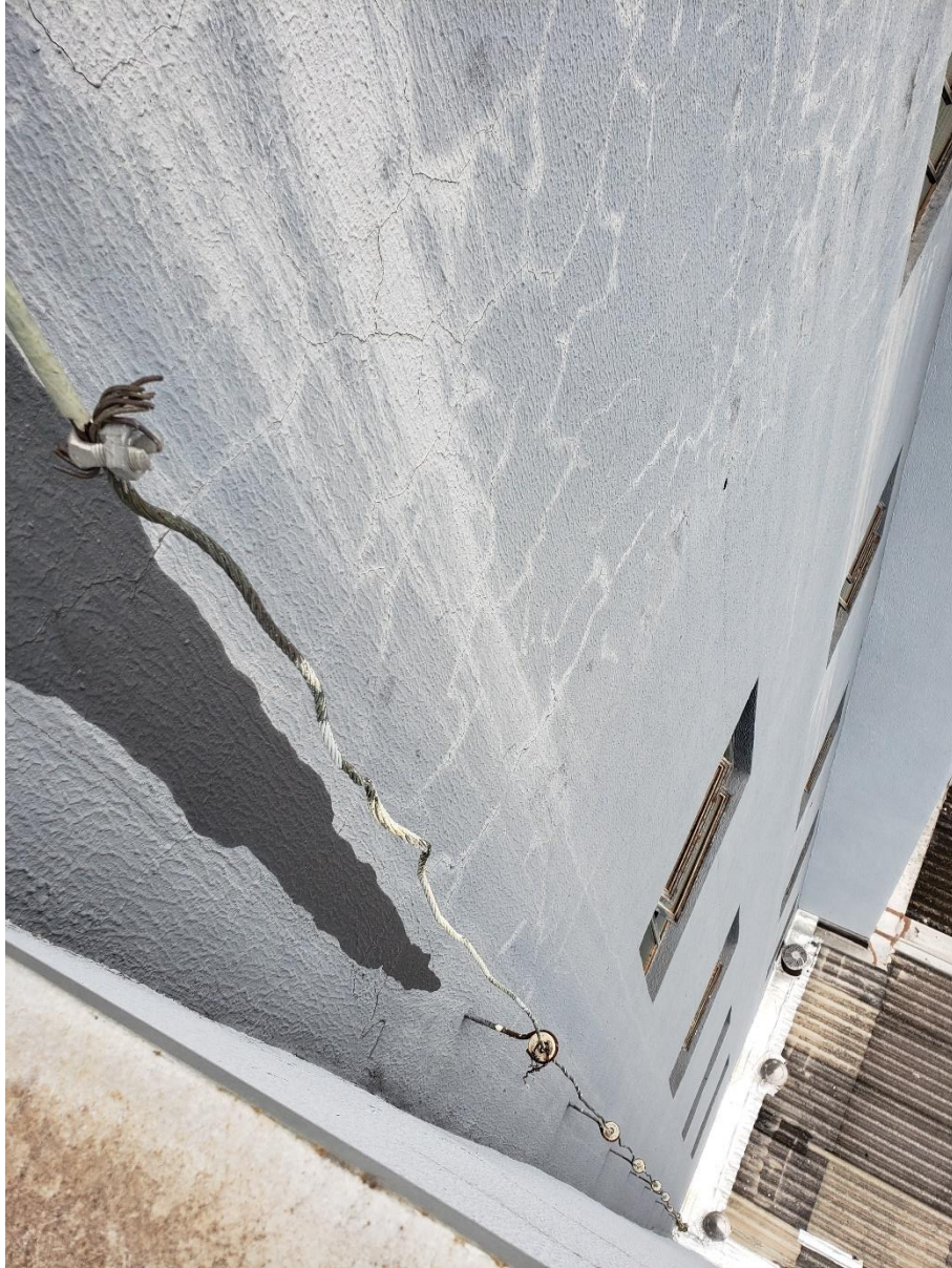
Imagem – Espaçadores e descida SPDA.
